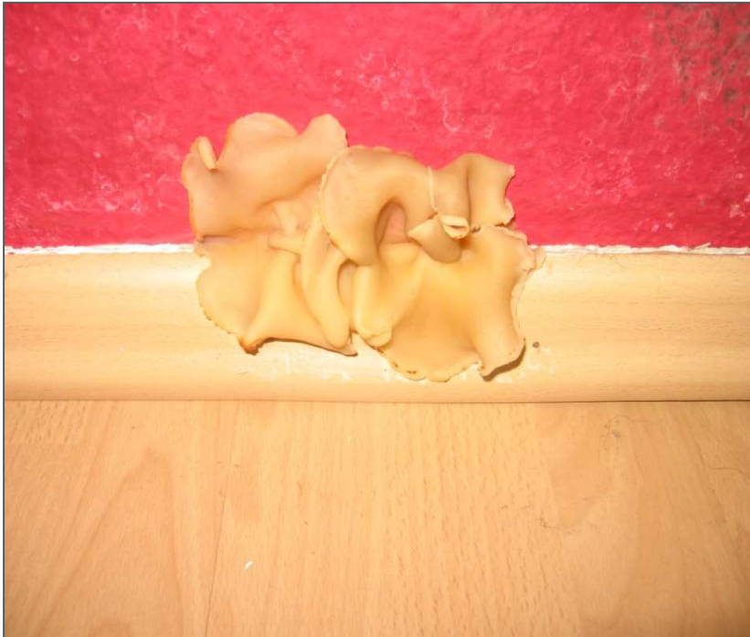
ein „Becherling“ hinter einer Fußleiste ...
