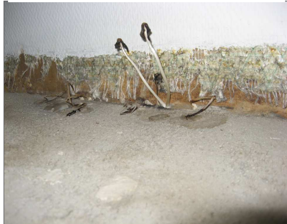
ein „Becherling“ hinter einer Fußleiste ...
